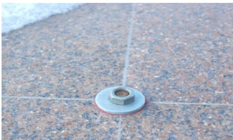
Рисунок 22 - Долговременный опорный пункт (Тип 3)
