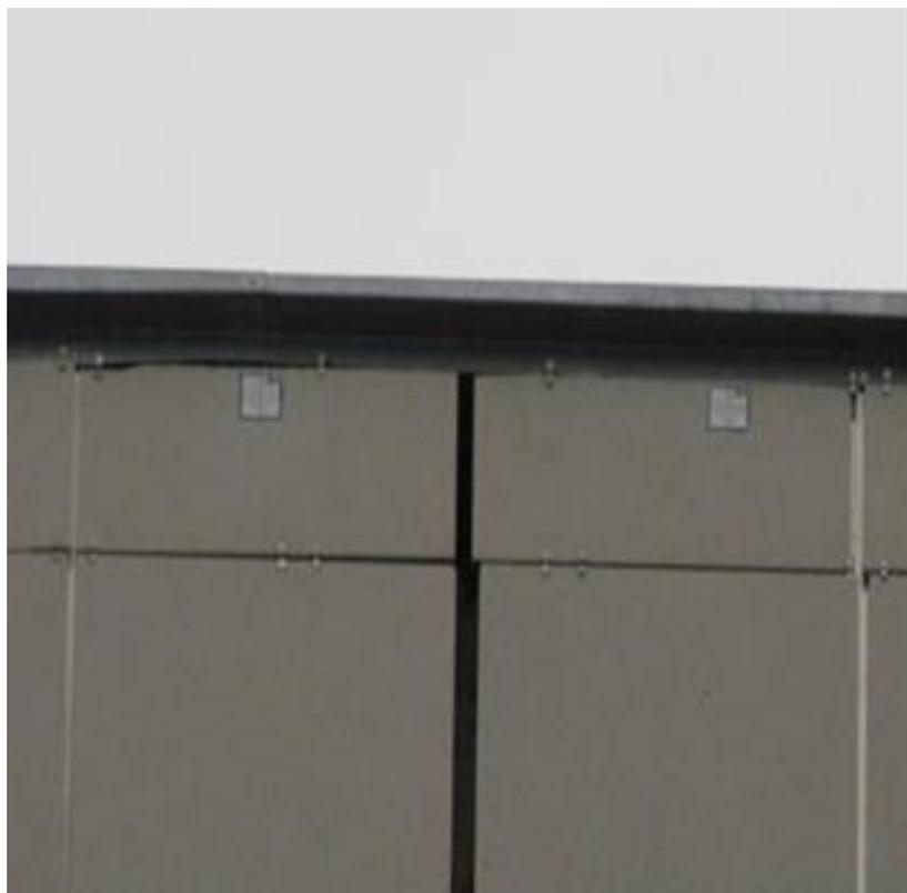
Рисунок 30 - Мониторинговые точки из отражающих наклеек на крыше здания
