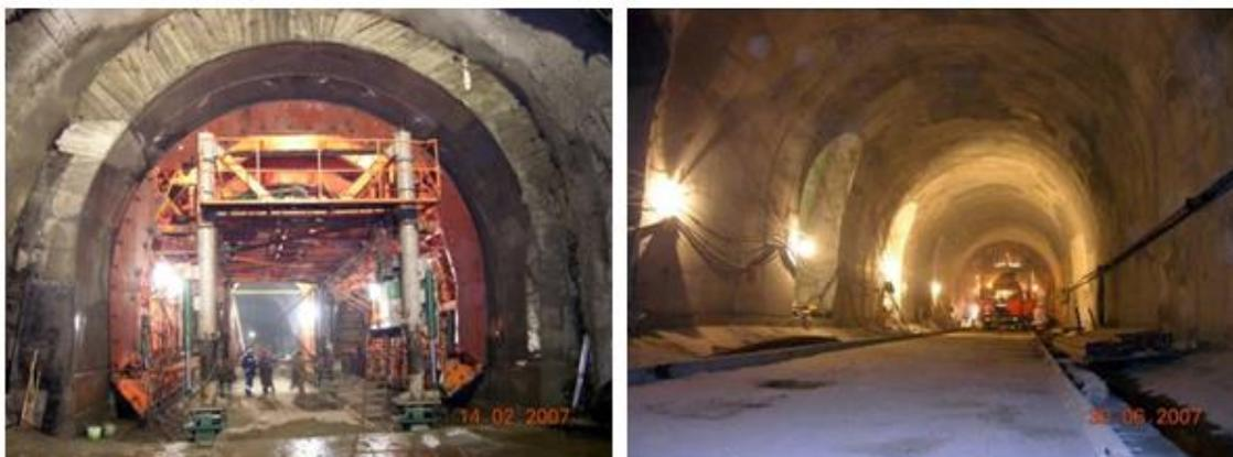
Рисунок 9- Самоходная станция опалубки и постоянная обделка боковых стен тоннелей
