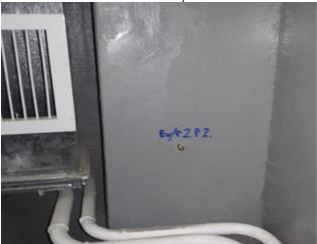
Рисунок 34 - Мониторинговые нивелирные точки на стенах цокольного этажа здания и паркингов
